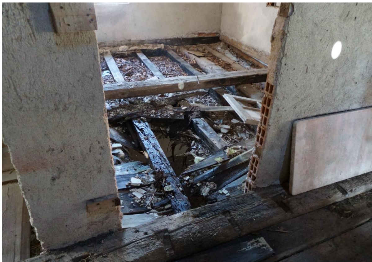
Figura 13 vista dall'interno, solaio interno danneggiato da infiltrazioni
