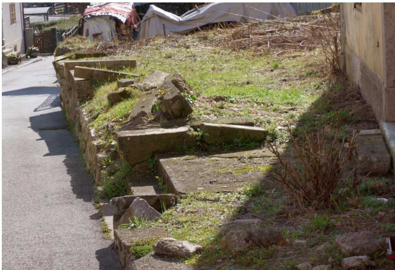
Figura 9 vista muretto di contenimento terreno lato strada con cedimenti
