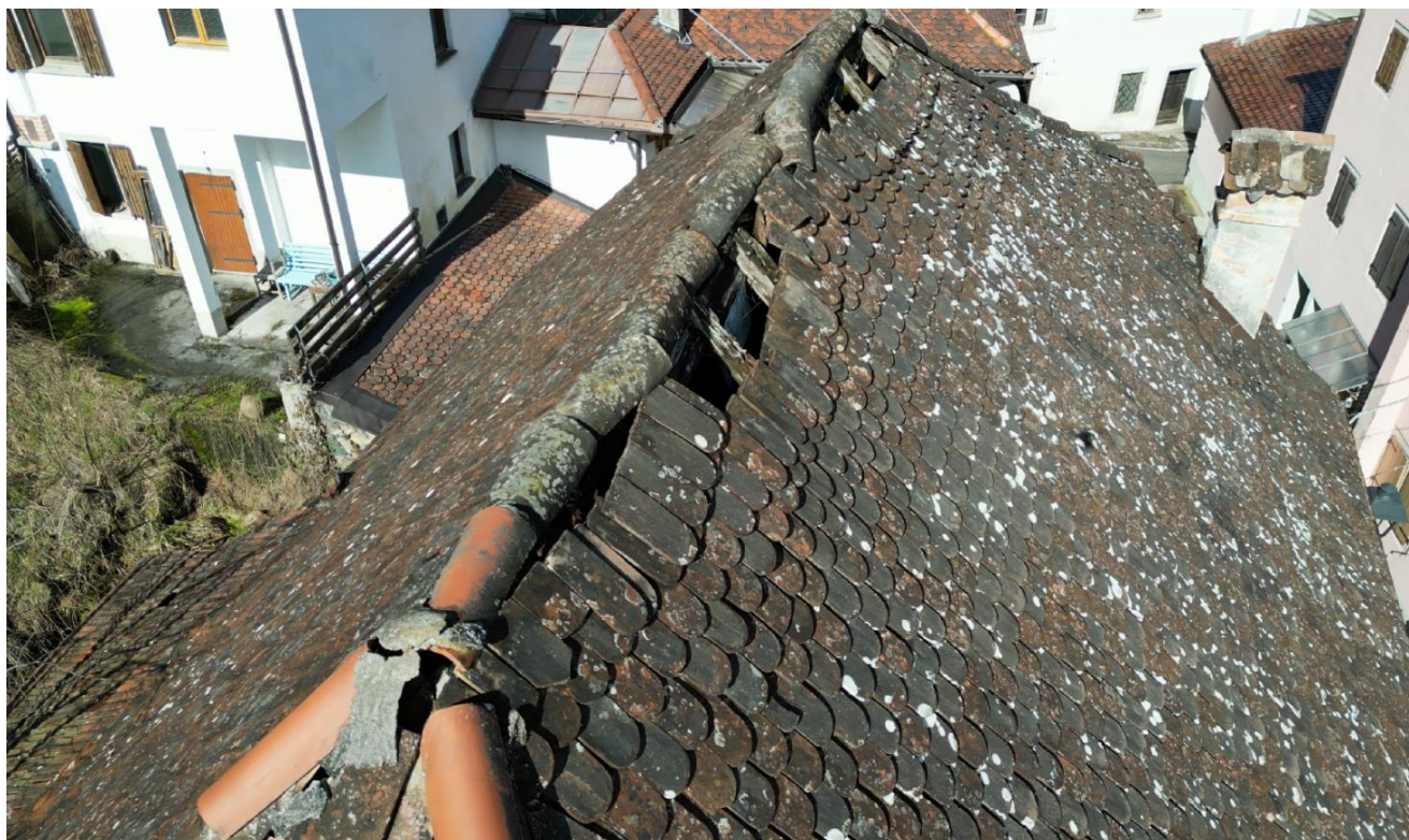
Figura 7 vista della copertura, danno su falda est in corrispondenza al colmo
