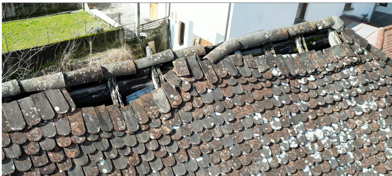
Figura 8 vista della copertura, particolare parte danneggiata
