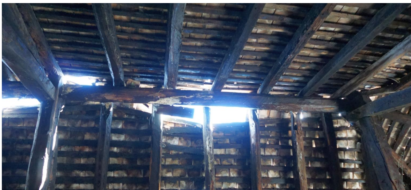
Figura 12 vista dall'interno, particolare discontinuità copertura
