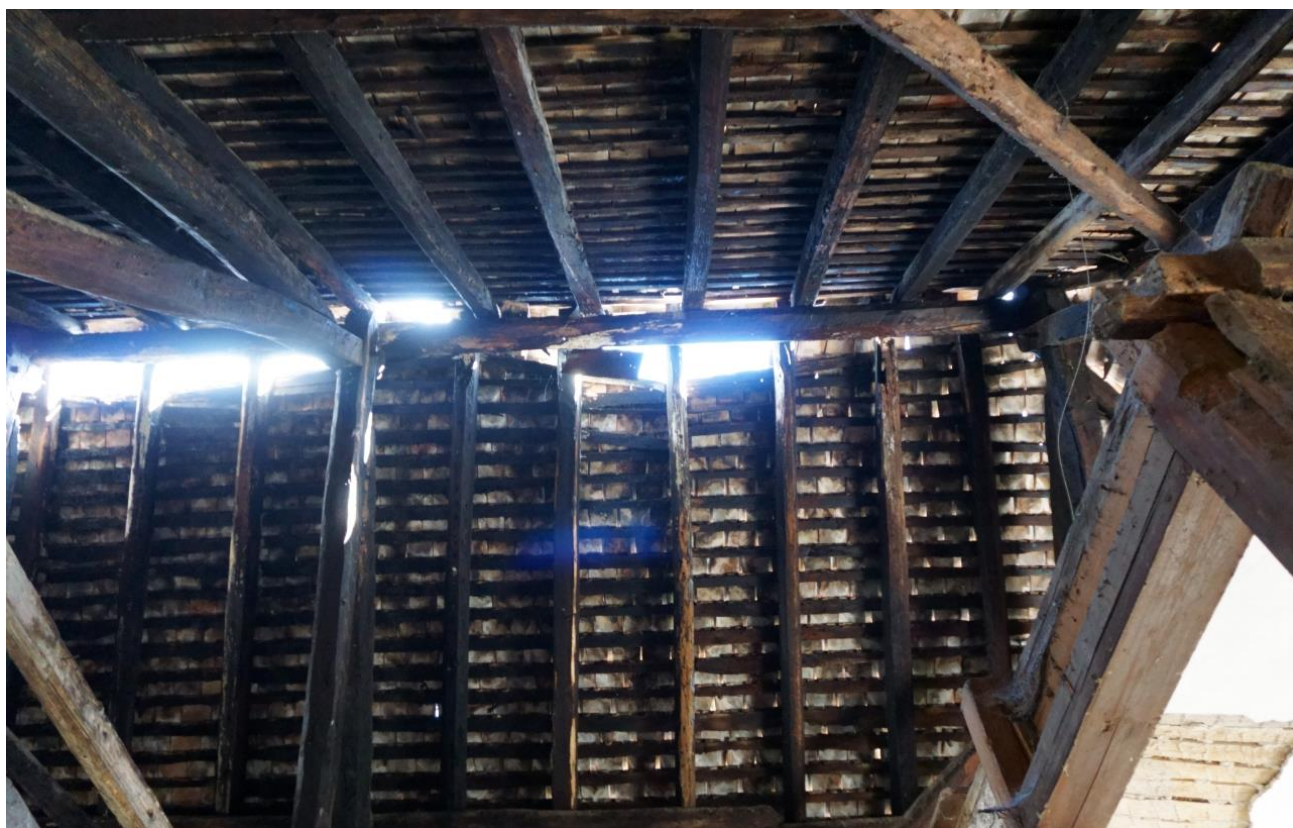
Figura 10 vista dall'interno, discontinuità della copertura
