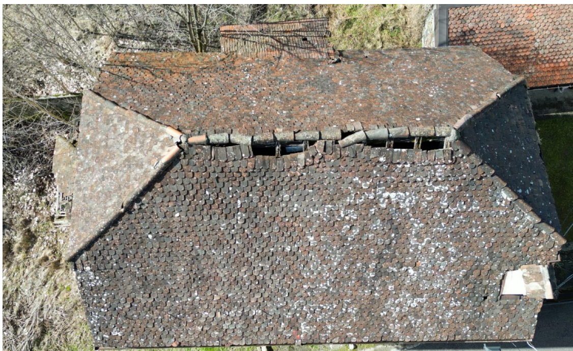
Figura 5 vista da drone, danno alla copertura falda est
