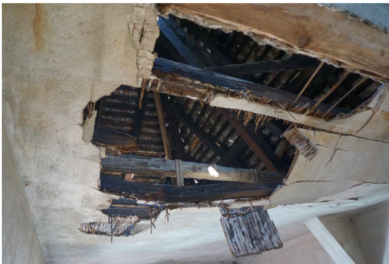
Figura 14 vista dall'interno, solaio intermedio danneggiato da infiltrazioni acqua
